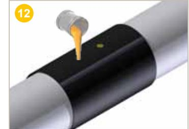
12) **Verser** le mélange dans l'un des trous d'injection de la manchette PEHD de diamètre 26 mm. Veiller à vider complètement le mélange en utilisant la spatule fournie à cet effet.
