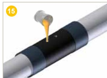
**Verser** le mélange dans l'un des trous d'injection de la manchette PEHD de diamètre 26 mm. Veiller à vider complètement le mélange en utilisant la spatule fournie à cet effet.
