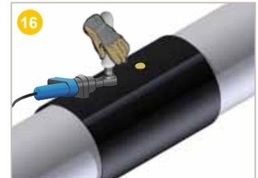
16) A l'aide d'un emporte-pièce, **ôter** le bouchon de fermeture à souder préalablement chauffé dans la machine à souder.
