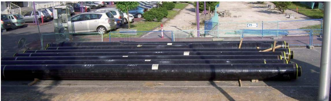
*En cas de stockage prolongé, les pièces stockées doivent être protégées avec des bâches. Les accessoires de chantier tels que isolants, feuillets, bandes thermo-rétractables, sont à stocker dans un local couvert et fermé.*
