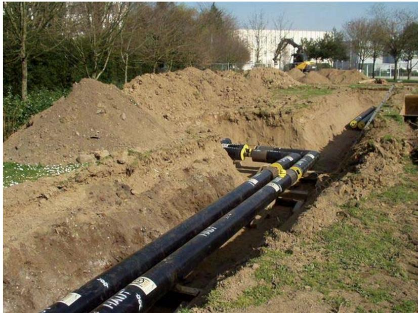
La dilatation reprise par chaque système est également limitée par le diamètre de la gaine extérieure qui impose une valeur maximale au déplacement du tube intérieur. Dans certains cas où la dilatation à reprendre est trop importante il est possible d'accroître localement le diamètre de la gaine TUCAL.
