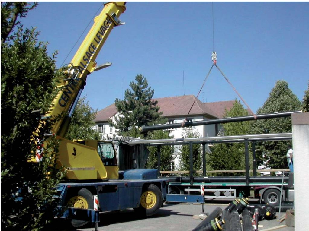
Des appareils de levage répondant à la réglementation en vigueur devront être choisis en fonction de la fragilité, de la masse et de l'encombrement des éléments à soulever. Les sollicitations humaines sont à limiter autant que possible.
