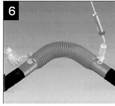
Instalar los tapones de cierre y colocar las pastillas termoretráctiles (ver imágenes 28 a 36 puesta en obra Kit inyectado Manguito i1)
