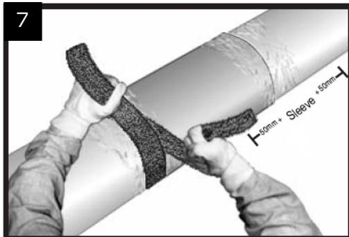
Hacer que la superficie sea rugosa (anchura del manguito + 100 mm a cada lado) utilizando papel de lija (grano 40-60) o en su defecto mediante un cepillo metálico.
