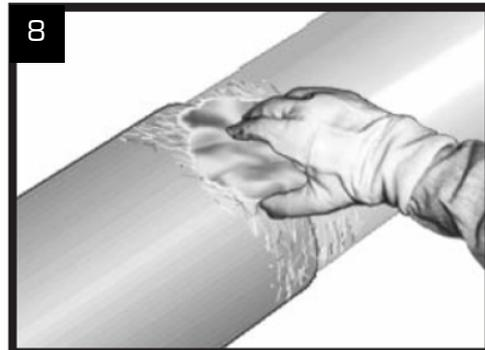
Limpiar la superficie ahora rugosa para quitar cualquier partícula de polietileno o de arena utilizando un trapo seco (o el soplo de la llama).
