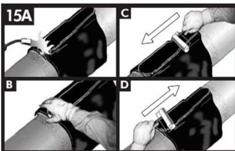
Calentar ligeramente el soporte del cierre y deslizar con la mano protegida con un guante. Repetir el movimiento de lado a lado para evitar cualquier pliegue. Evacuar las burbujas de aire mediante un rodillo.
