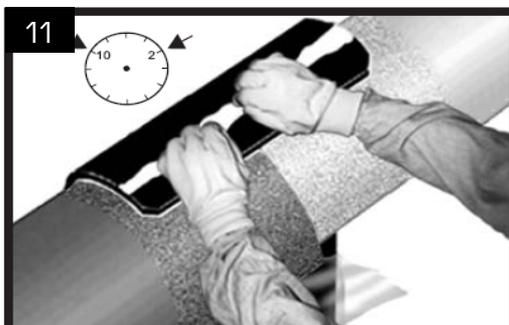
Centrar el manguito en la junta de tal modo que el solape se haga entre las posiciones 10 y 2h. Montar firmemente el extremo.
