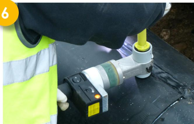
6 Afin d'assurer une étanchéité à toute épreuves, les trous nécessaires à l'injection de la mousse PU sont ensuite scellés par soudure d'un bouchon en PE.
