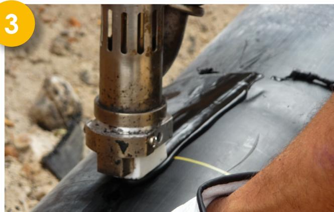
3 Pour parfaire l'étanchéité de la jonction, la coupe longitudinale de la manchette est soudée par extrusion de PE
