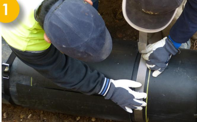
1 Après avoir correctement nettoyé et dégraissé les surfaces à souder (gaine et manchette). Des grilles de fusion sont ensuite installées et maintenue sur la gaine du tube, la manchette PEHD est coupée longitudinalement puis mise en place.
