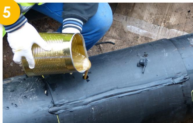
5 L'isolation est réalisée en mélangeant les composants de la mousse polyuréthane puis en versant le mélange dans la jonction.
